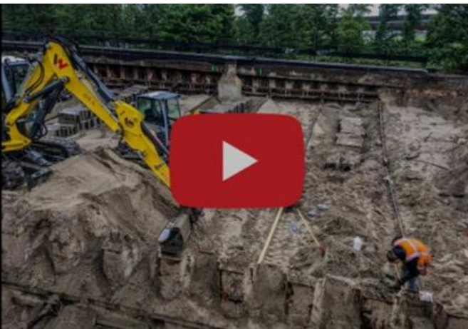
- video renovatie Vlechtingsviaduct -
